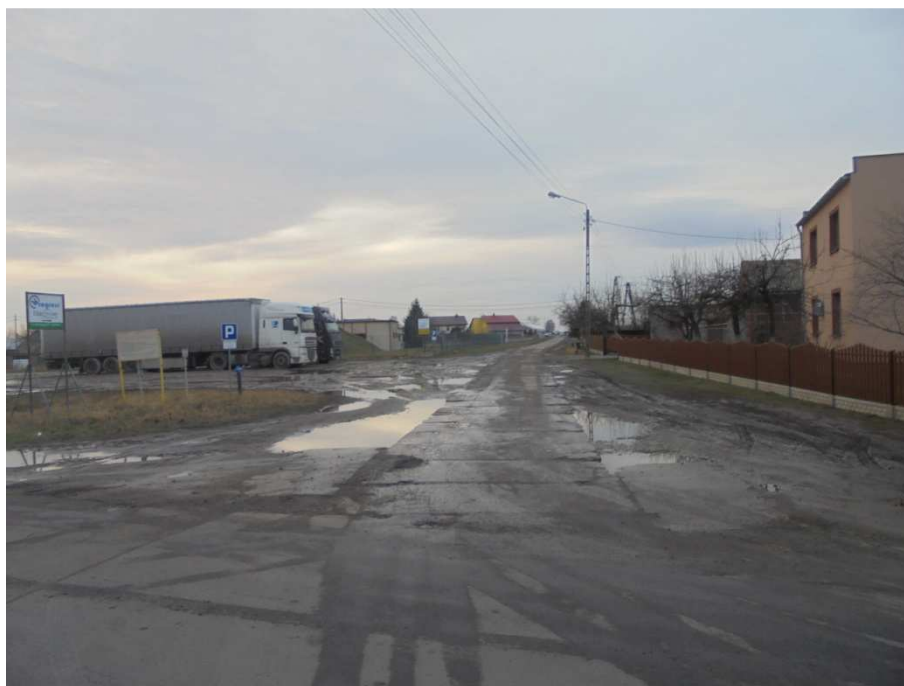
Stan istniejący nawierzchni drogi gminnej o długości ok. 350m - widok od drogi powiatowej Nr 5682P Bralin - Rychtal
