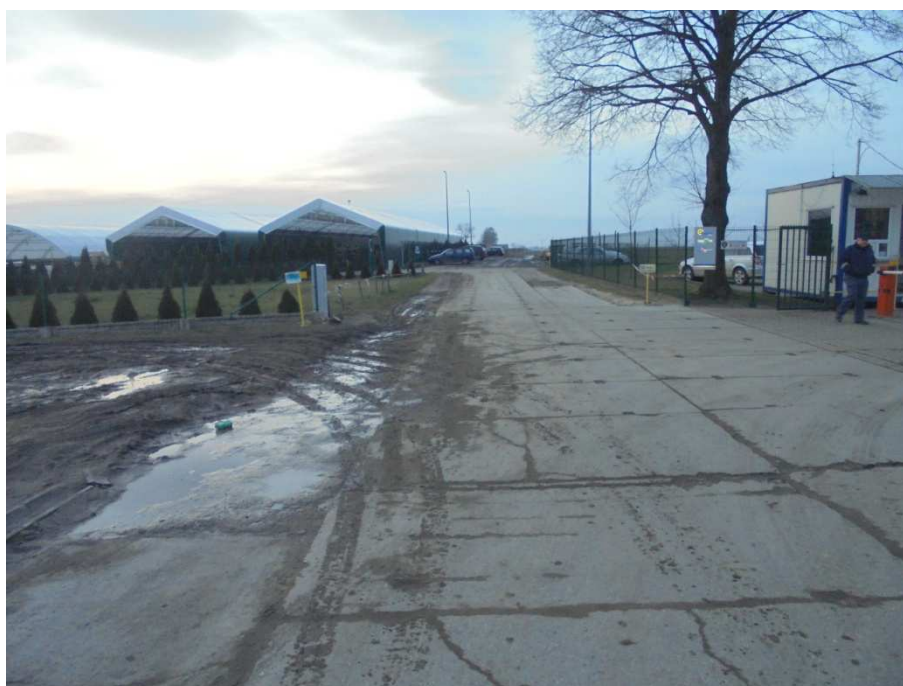
Stan istniejący nawierzchni drogi gminnej o długości ok. 350m
