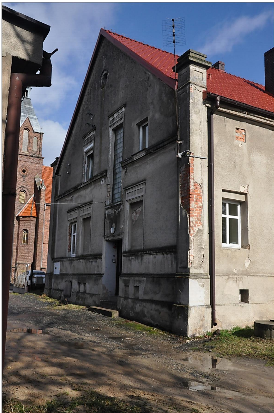
architekt Przemysław Wierzbicki 62 872 Żydów k. Kalisz ul. Szkolna 65 & Fot.7. Budynek: dawnej pastarówki przy ul. 3 Maja 9. Widok ogólny elewacji bocznej zachodniej.
