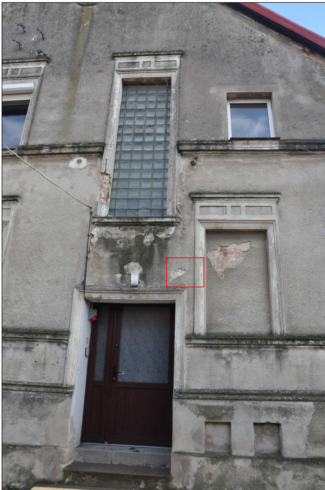
Fot.8. Budynek: dawnej pastorówki przy ul. 3 Maja 9. Fragment elewacji bocznej zachodniej. Kolorem czerwonym oznaczono miejsce analizy nawarstwień tynku opisane na fotografii 9
