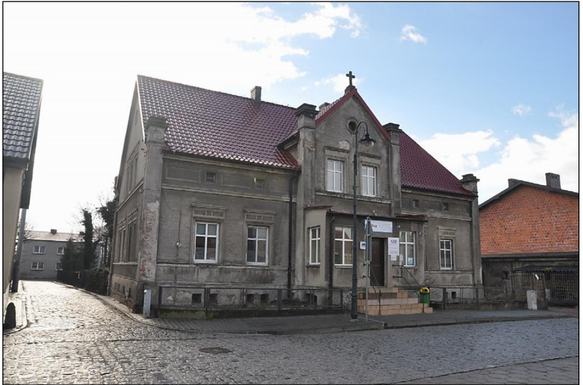
Fot.1. Budynek: dawnej pastorówki przy ul. 3 Maja 9. Widok ogólny fasady.
