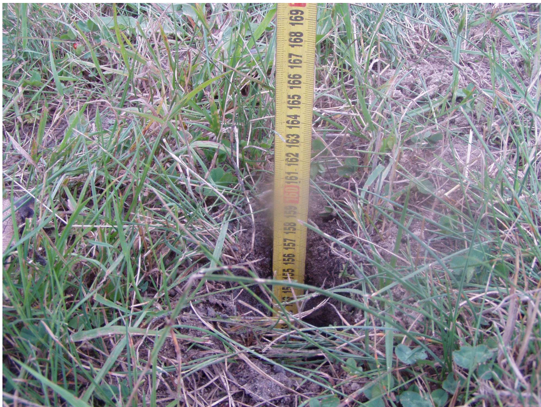
Wykonywanie odwiertów w poboczu Odwiert nr 3 km 0+930
