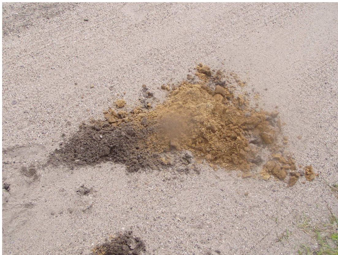
Wykonywanie odwiertów w istniejącej nawierzchni drogi 20cm ziemia, 100cm piaski gliniaste
