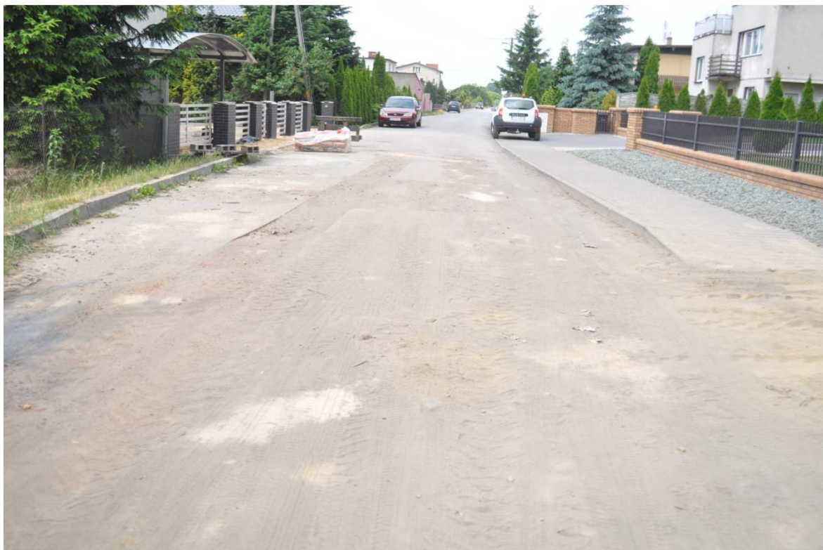
Stan istniejący nawierzchni ulicy Nowej i Rzemieślniczej w Bralinie Początek Zakresu Opracowania
