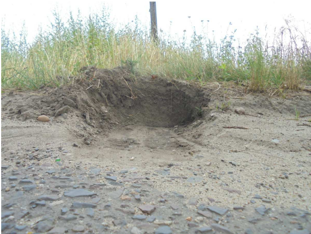
Ścinka zawyżonych poboczy gruntowych
