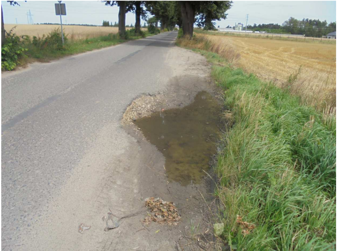
Naprawa i uzupełnienie ubytków w nawierzchni drogi gminnej
