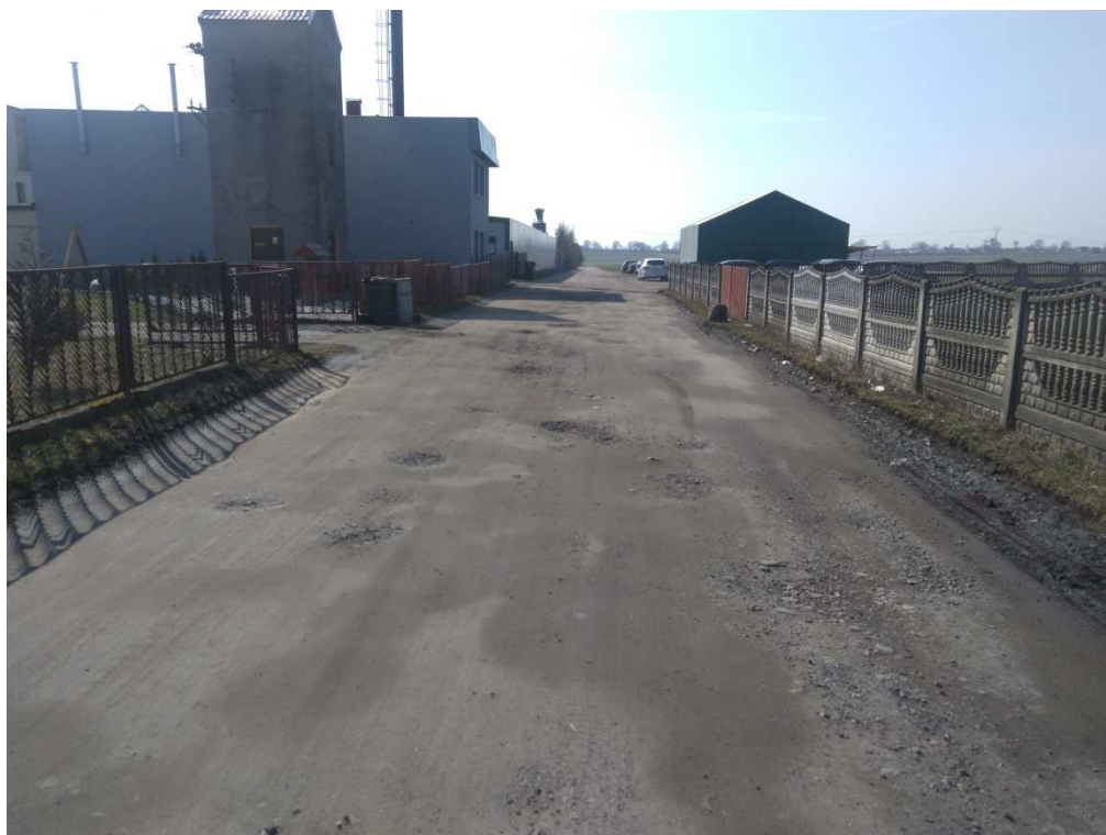
Stan istniejący nawierzchni tłuczniowej
