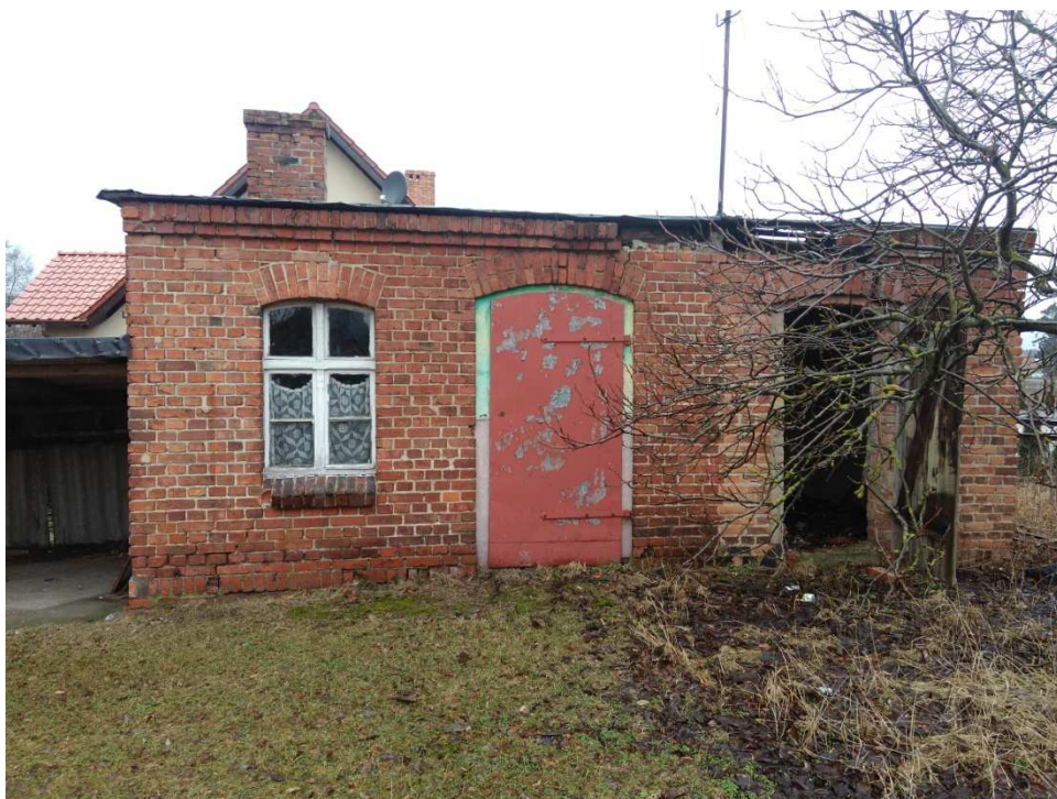
Budynek gospodarczy podlegający rozbiórce
