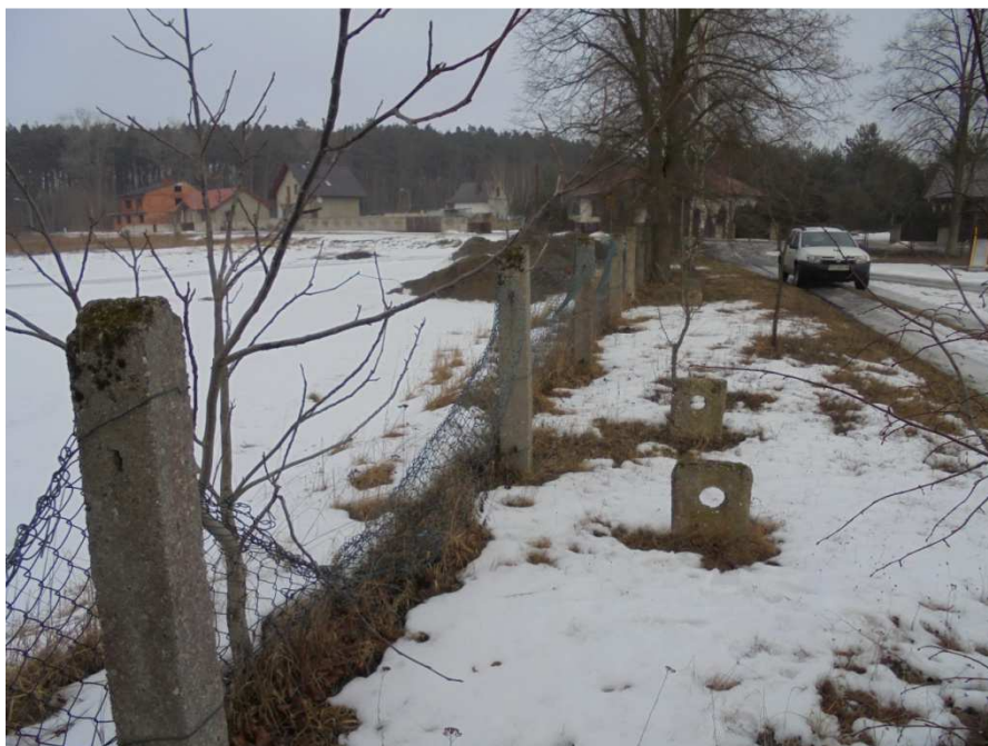
Ogrodzenie z siatki stalowej na betonowych słupkach
