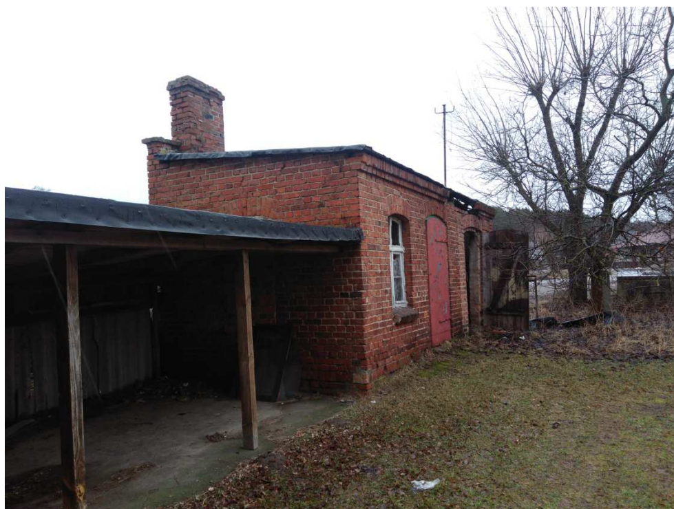
Budynek gospodarczy c.d.. podlegający rozbiórce
