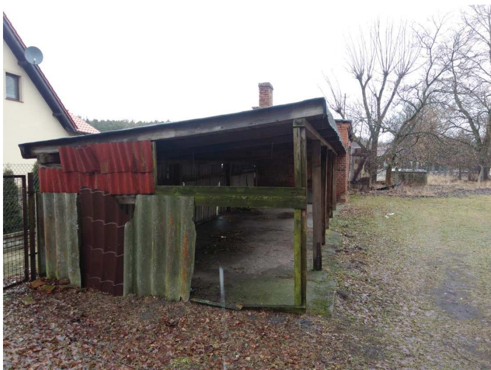
Budynek gospodarczy c.d.. podlegający rozbiórce
