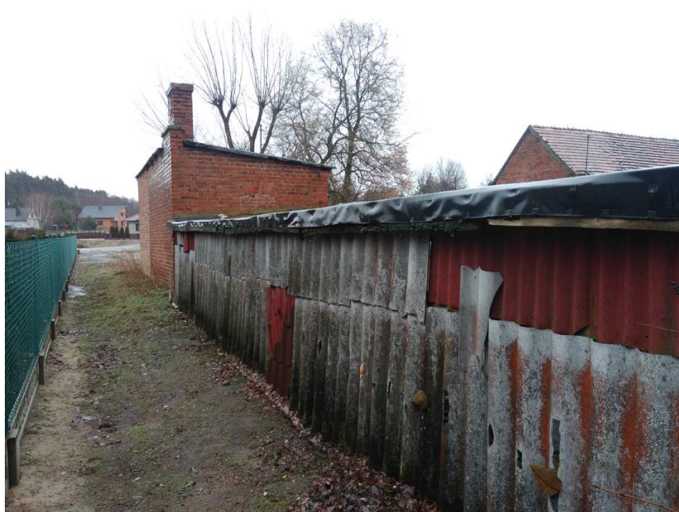
Budynek gospodarczy c.d.. podlegający rozbiórce
