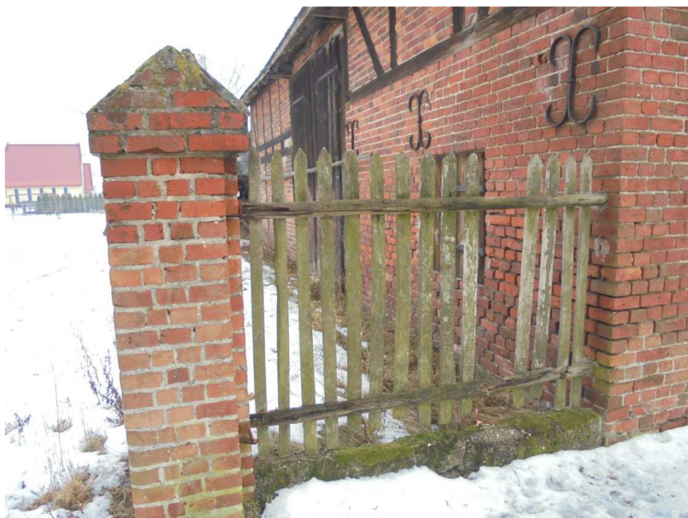
Ogrodzenie z paneli drewnianych z ceglany słupkiem
